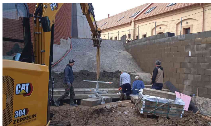
Stavba schodů u zvonice kostela
