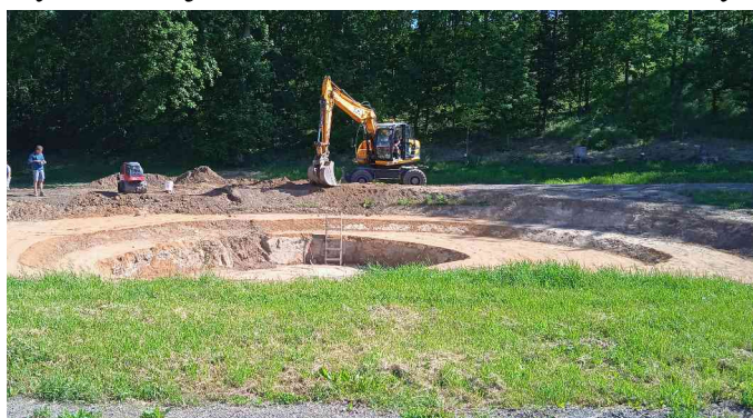
Hloubení jezírka v květnu
