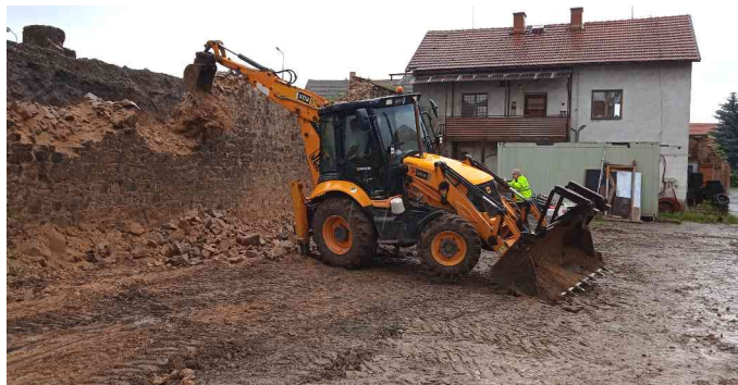
Demolice staticky porušené zdi
