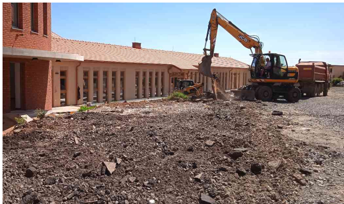
Odstraňování asfaltu na horním dvoře
