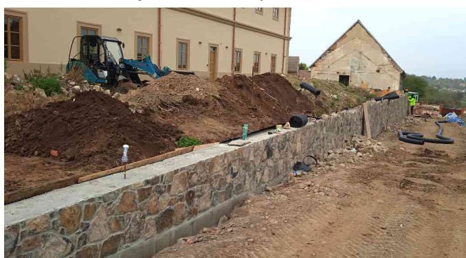
Budování opěrné zidky u budoucí terasy
