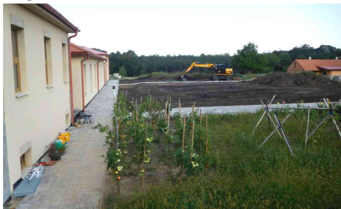
Zavážení a zarovnávaní zeminy na naší budoucí pěstební zahradě
