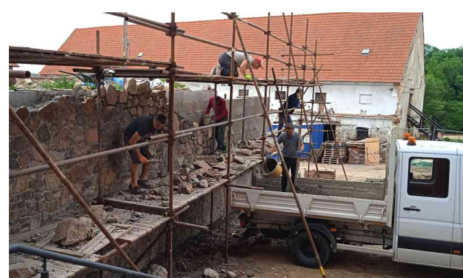
Opěrná zeď a její obkládání kamenem
