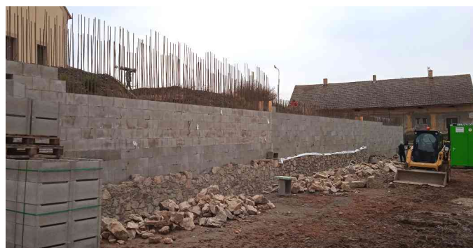
Stavba nové zdi na podzim
